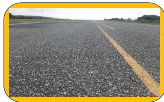
**Gambar 2.** Kondisi landasan dengan lapisan permukaan aspal yang lepas lepas
