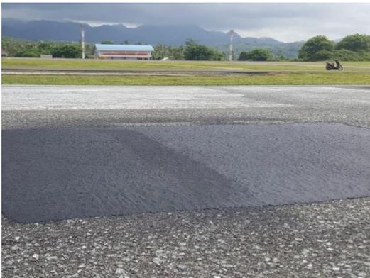
**Gambar 3.** Hasil perbaikan Landasan di Bandara Gatot Subroto dengan dilapis aspal setebal < 1 cm.
